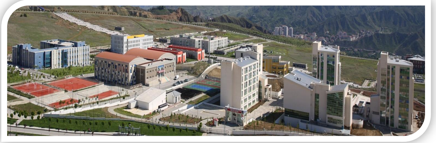
Şekil 5. Uluyazı Yerleşkesinden Bir Kesit.
