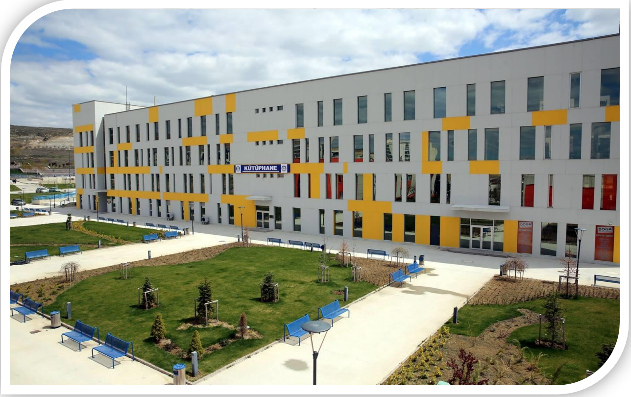
Şekil 7. Üniversitemiz Kütüphane Binasından Bir Kesit.
